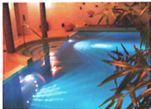
Die Wasserpflege mit Kupfer- und Silberionen funktioniert bei Freibädern und Schwimmhallen gleichermaßen.
